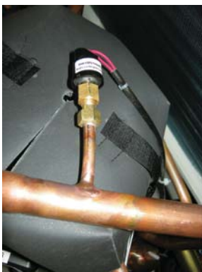
Предохранительный клапан низкого давления
